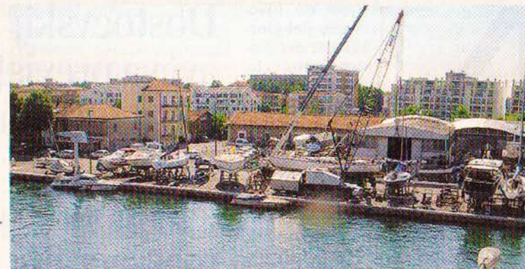
Nel mese di marzo gli studenti hanno anche effettuato una visita ai cantieri navali e al porto di Rimini, con un'uscita sulla palata del molo di levante per osservare i danni provocati dalla più recente mareggiata
